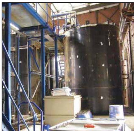
یک سیستم صنعتی پیاده‌سازی شده برای تصفیه انتخابی نیترات
