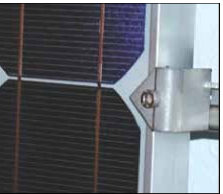
شکل ۴- ساخت چهارچوب پنل‌های خورشیدی از جنس فولاد زنگ‌نزن دوفازی کم‌آلیاژ.
