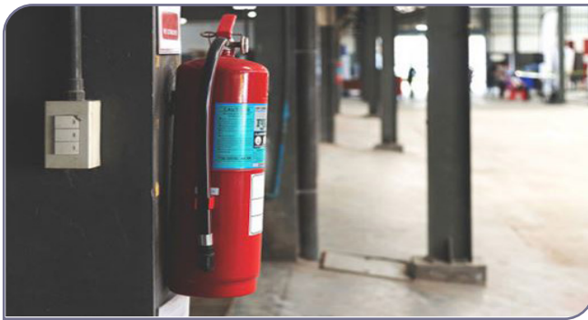
شکل ۳-۹. نصب خاموش کننده در انبار
