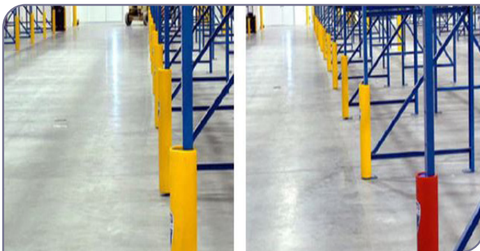
شکل ۳-۳. حفاظت از پایه‌های قفسه‌ها
